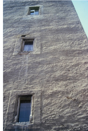
1. St. Wolfgang, Oberrösterreich, Pacheraltar, (1471) Werkstattseite, Detail. Die Träger des Gerüsts, Netzriegel genannt, werden beim Aufmauern auf die Mauer gelegt und mindestens 40 cm hoch mit Mauersteinen beschwert, sodass Pfosten, also Gerüstbretter aufgelegt werden konnten. Dies erklärt auch die geringe Etagenhöhe von ca 1 m. Beim Abgerüsten wird der Putz etagenweise hergestellt. Die Ressourcen schonende Verwendung von Holz entspricht auch der Entwicklung der Produktivkräfte. Mühlen mit Gattersägen wurden erst Anfang des 16. Jh. entwickelt. Foto BDAI/Mejchar; 2. Krems/Niederösterreich, Passauerhof, Turm, um 1300, Putz im 15. Jh. repariert, mit dem Netzriegelgerüst hergestellt. Foto: Ivo Hammer, 1991
