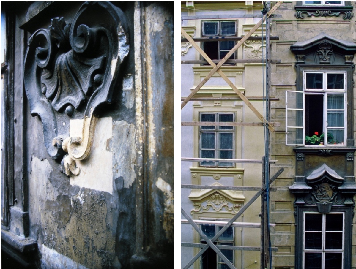
22–23: Wien 1, Singerstr. 18, Fassade um 1720 Untersuchung und Reparatur in traditioneller Kalktechnik 1986 durch die Restaurierwerkstätten des BDA/Ivo Hammer, Mitarbeit von Peter Berzobohaty, Claudia Podgorschek, Carmen Chizzola und Bettina Fischer; (22): Sondierung, 6 Übertünchungen der Kalkfassade, davon zwei Leinölanstriche (ca. 1820? und 1880?); re.: Pilotfläche (eine Fensterachse) nach Abschluss der Reparatur. Die erste Anwendung der Kalktechnik in Wien, nachdem 15 Jahre lang nurmehr mit Dispersionsfarben gestrichen wurde. Fertigstellung der Restaurierung in Kalktechnik durch Stuckrestaurator Josef Souchill. Fotos Ivo Hammer 1986
