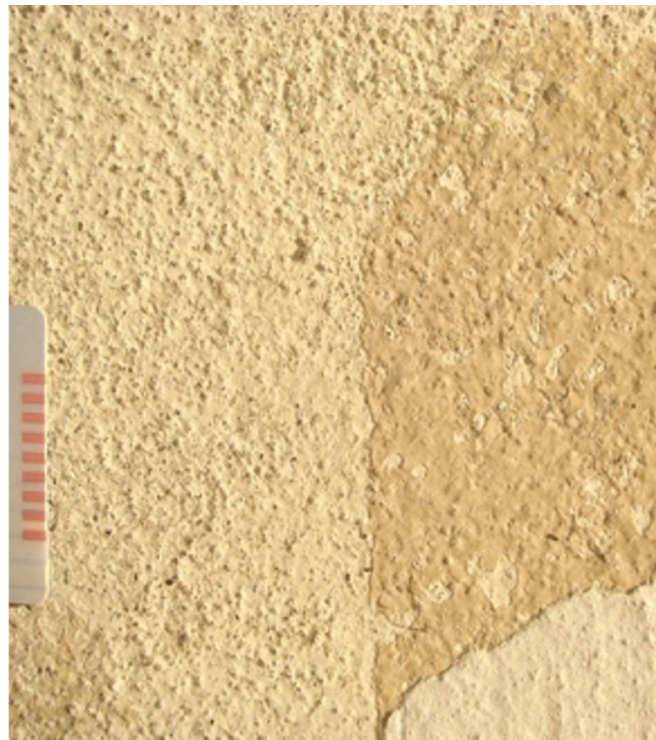
3. Melk/Niederösterreich, Stiftskirche, um 1740, Westfassade, Detail, Zustand 1977. Die Fassade und ihr Stuck und Putz wurde mit einem frei stehenden Gerüst hergestellt und wurde ca. alle 30-50 Jahre mit Kalktünchen gepflegt; 4. Bmo/CZ, Haus Tugendhat, Ludwig Mies van der Rohe 1928-30. Traditioneller geriebener Fassadenputz (KZM) mit dünner, mit feinem Sand gefärbter Kalktünche
