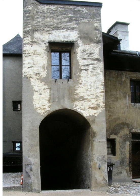
25. Feste Hohensalzburg, östlicher Burghof, Treppenaufgang, 17. Jh., mit Reparatur aus geriebenem Kalkzementputz (30er Jahre 20. Jh.)
