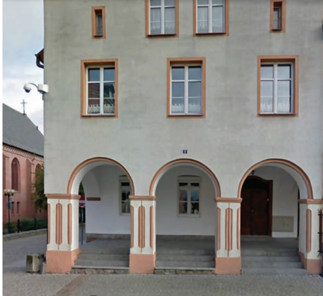
3. Olsztyn (Polska), rekonstrukcja z lat sześćdziesiątych XX w. budynków Stare Miasto 1 i kościoła ewangelickiego – tradycyjne powierzchnie wapienne. Polska tradycja rzemieślnicza była wciąż żywa (fot: widok ulicy z Google maps, 2017)
