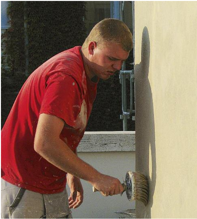
4 Brünn, Haus Tugendhat, obere Terrasse, Südwestfassade, Handwerker bei der traditionellen Technik der Fassadenrepa- ratur mit einer Kalktünche, die von Kon- servatoren-Restauratoren konfektioniert wurde
