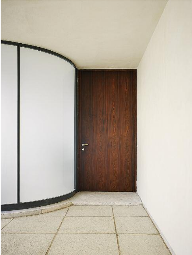
5 Brünn, Haus Tugendhat, Eingangsbereich, nach der Rekonstruktion der runden Glaswand und Restaurierung
